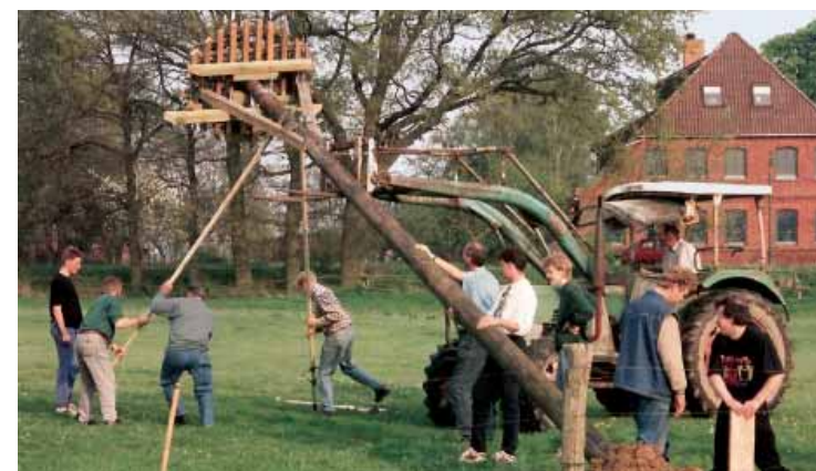
Errichtung einer Nistunterlage
