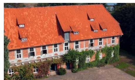
Demnächst mit Gerüst – der Nordflügel des Schlosses
